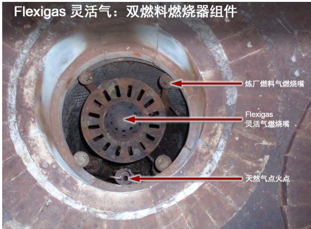
图 6：Flexigas 灵活气：双燃料燃烧嘴组件
